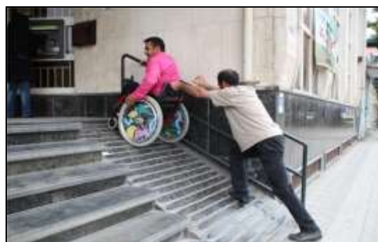
شکل ۳. طراحی شیب نامناسب برای صندلی چرخدار در یکی از ادارات شهر بندر ماهشهر
