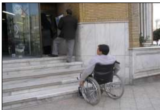
شکل ۲. نبود رمپ مناسب جهت عبور صندلی چرخدار در یکی از بانک‌های شهر بندر ماهشهر
